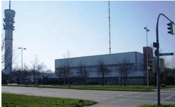
Halle am Fernsehturm – Fläche 5000 m 2
